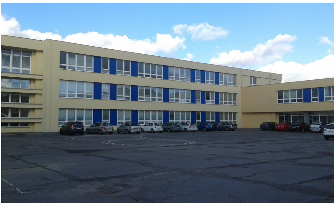
Obrázek č. 12: Školní dvůr v areálu Základní školy JUDr. Josefa Mareše a Mateřské školy Znojmo, Klášterní náměstí 2, Znojmo. Zde mají žáci možnost nacvičovat jízdu na kole. Na zemi jsou namalovány prvky dopravního značení (Zdroj: vlastní).
