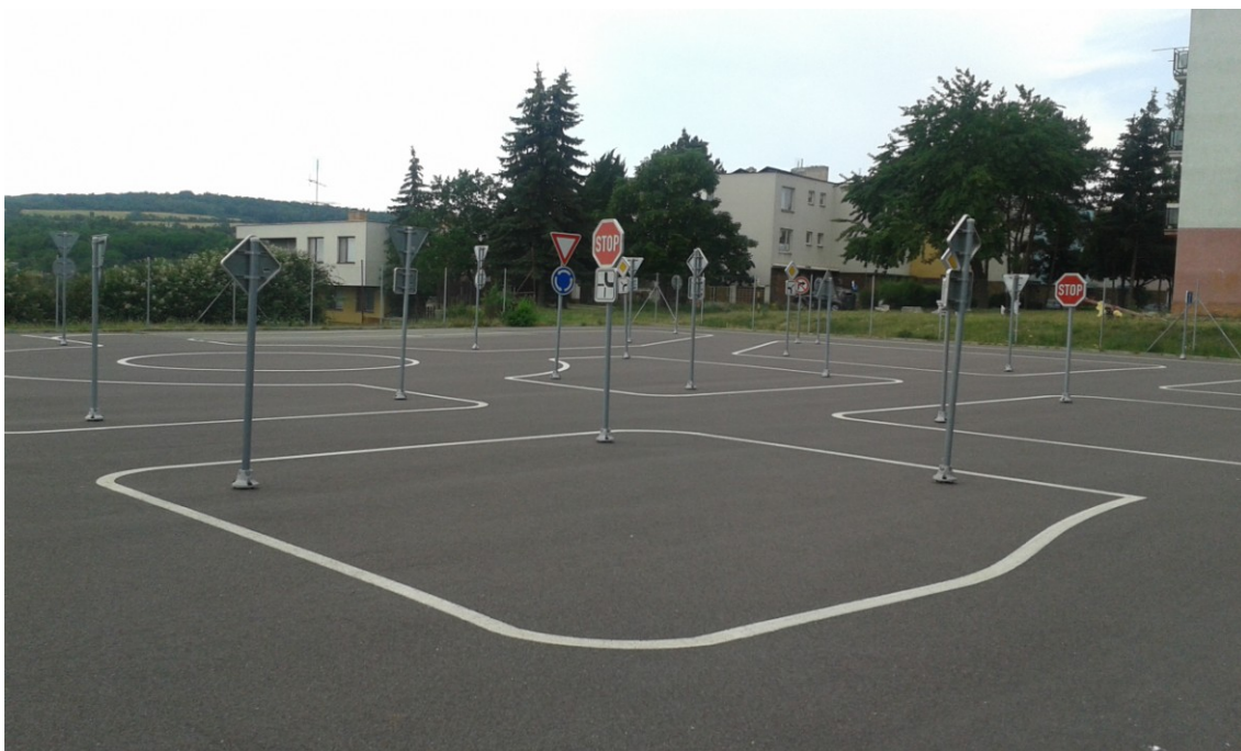
Obrázek č. 19: Dětské dopravní hřiště na ulici Jindřicha Hořejšího (Zdroj: vlastní).
