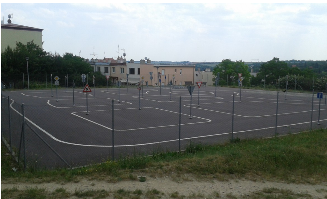
Obrázek č. 18: Dětské dopravní hřiště na ulici Jindřicha Hořejšího (Zdroj: vlastní).
